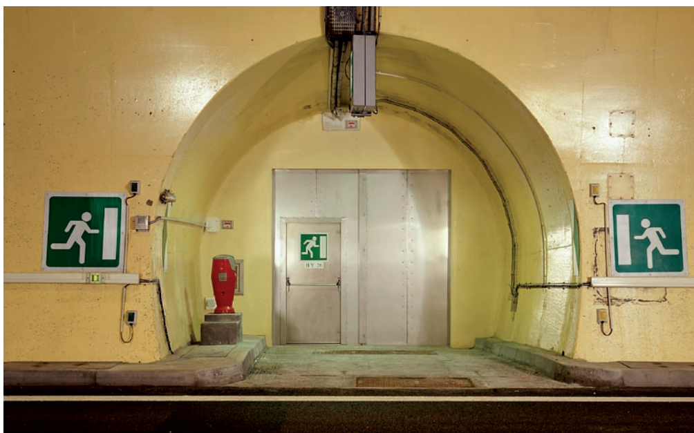
Porte intertube HCM autorisant le passage des véhicules de secours.
